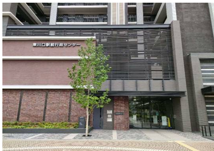
東川口駅前行政センター （令和 6 年 5 月開所）
