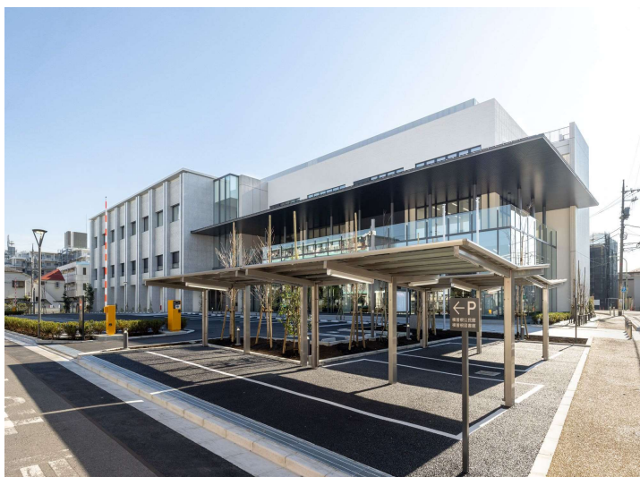
川口市立横曽根公民館・川口市立横曽根図書館 (令和 7 年 11 月竣工)
