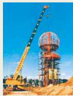
昭和60年 展望スベリ台の設置
