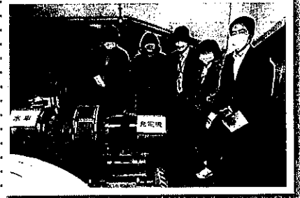
横曽根浄水場の小水力発電設備を視察
