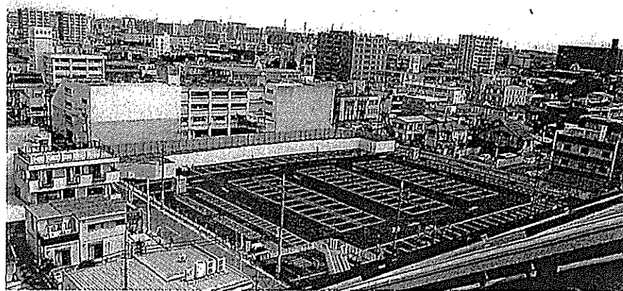
【仮設の平面駐車場、左奥の建物が解体される立体駐車場】
