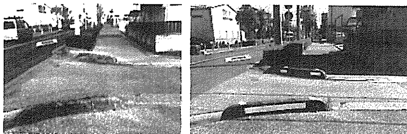
【 危険な縁石に反射板設置 】
