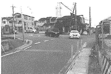
実績5 ポール設置 (北原台1-26付近)
