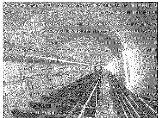
シールドマシンも順調に 280 m ほど進んでいます（R 3.3）
