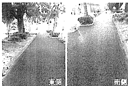
前川第1公園東側・南側外周の補修
