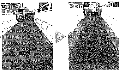
柳崎人道橋整備
