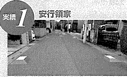
①スピードを抑止する路面塗布
