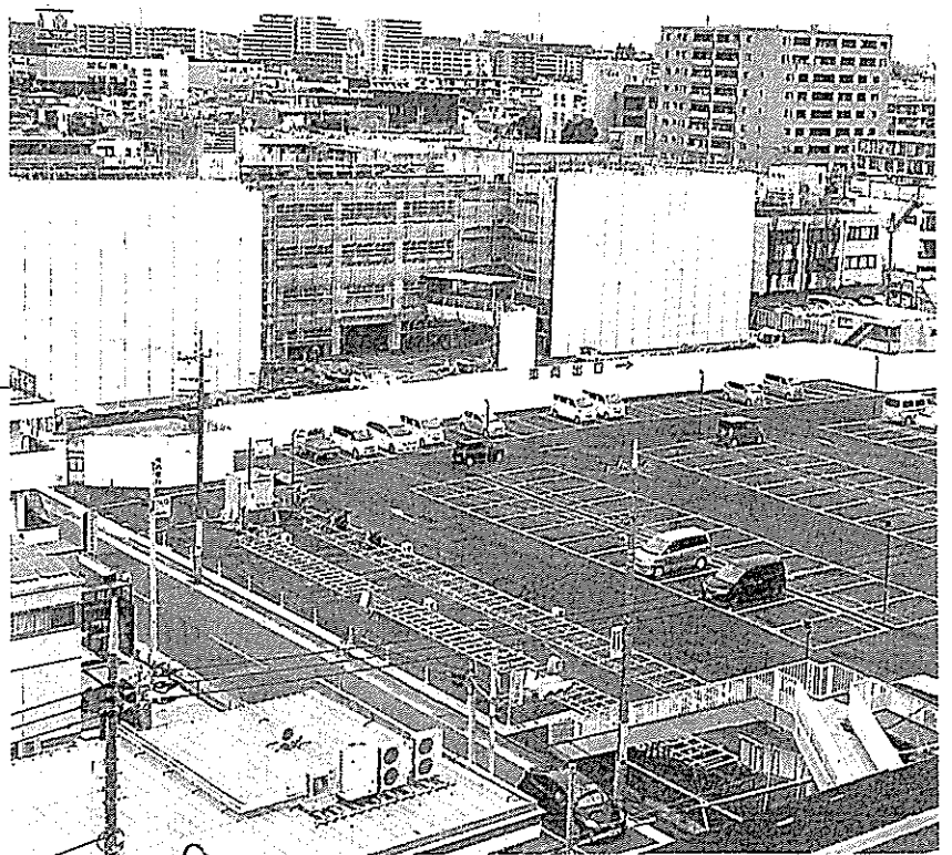
新庁舎の建設状況
