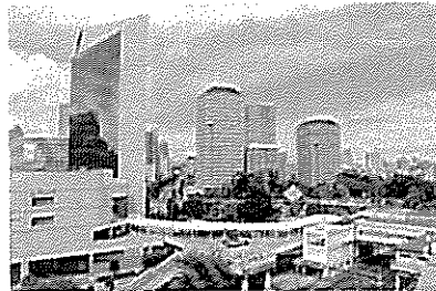
再開発により高層住宅が立ち並ぶ川口駅周辺
