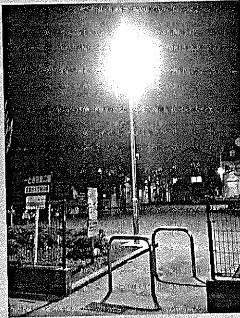
芝富士1丁目公園にLED照明灯の増設
