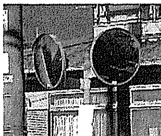
▲ 安行領根岸の2面カーブミラー ひび割れして見えなくなり 危険と伺いました。 担当部局へ連絡し新しいミラーに 交換していただきました。
