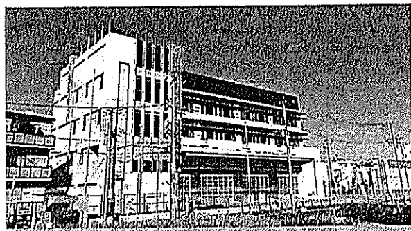
●東消防署全景
