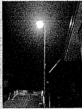
②木曾呂343-4付近 街灯の設置
