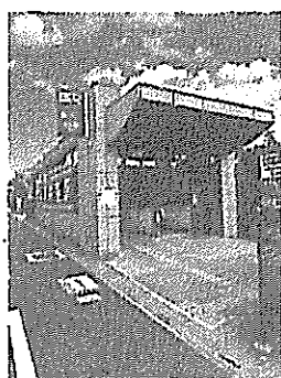
新井宿 出入口1 今後こちらに駅前広場が 移転予定
